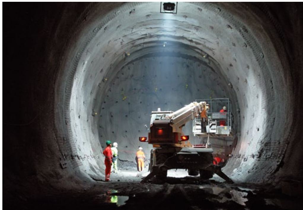
La percée principale de Sigirino en direction Nord se poursuit encore dans des conditions géologiques difficiles
