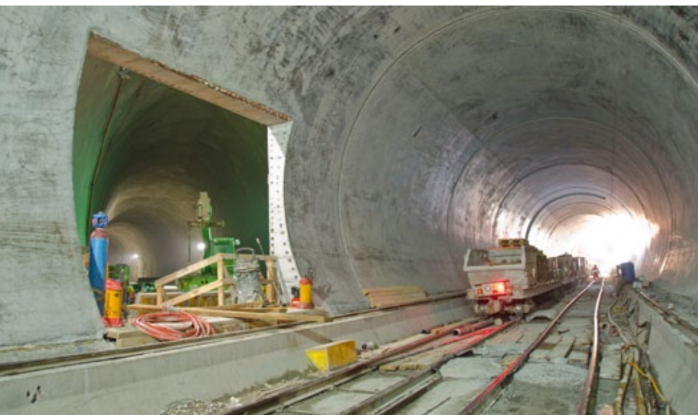
La galerie d'accès d'Amsteg et l'ouverture où seront posées les fenêtres destinées aux visiteurs.
